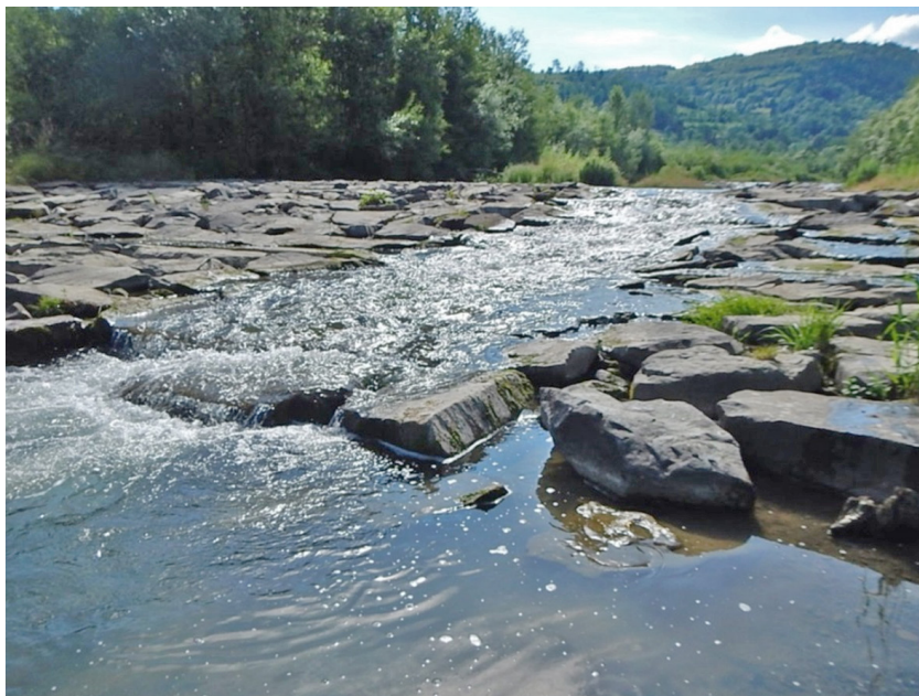
Ryc. 10. Widok na rozmycie poniżej bystrza o zwiększonej szorstkości – potok Porębianka (fot. A. Radecki-Pawlik)
