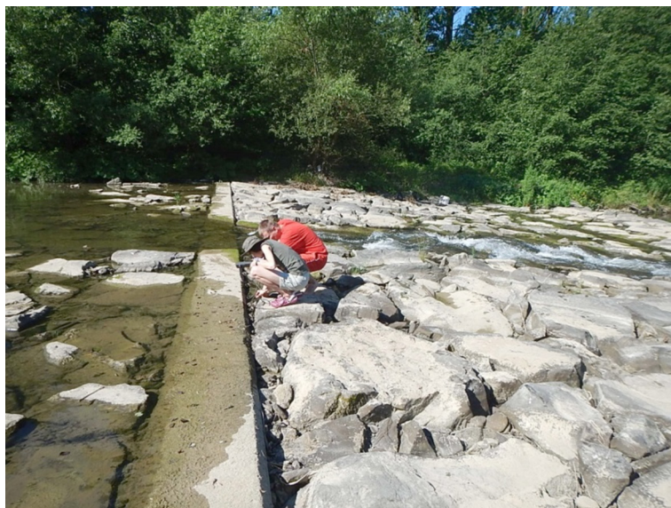
Ryc. 13. Widok na bystrze o zwiększonej szorstkości ze stalowym gurtem z oczepem betonowym – potok Porębianka (fot. A. Radecki-Pawlik)
