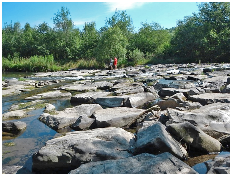
Ryc. 8. Widok na płytę spadową bystrza o zwiększonej szorstkości z kamieniem łamanym – potok Porębianka (fot. A. Radecki-Pawlik)
