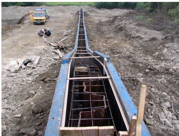
Ryc. 14. Widok na gurt stalowy z oczepem betonowym – potok Porębianka (fot. W. Wielgus, RZGW)
