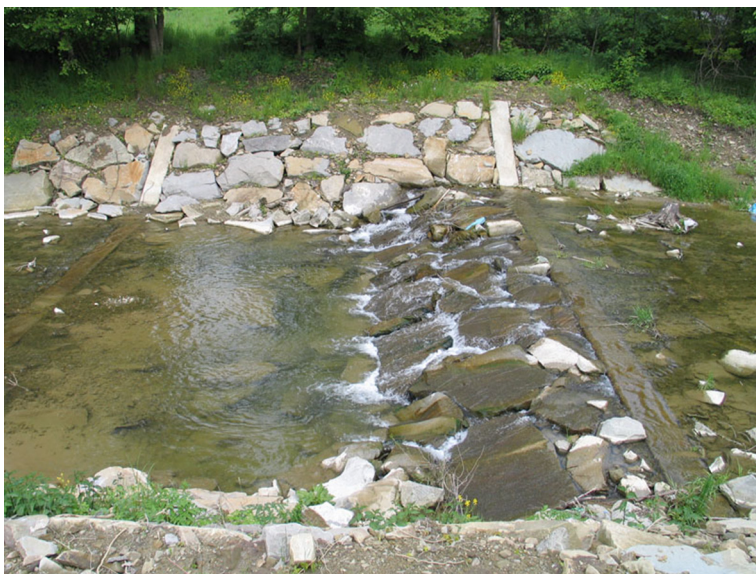
Ryc. 11. Widok na bystrze o zwiększonej szorstkości z gurtem betonowym – potok Jachówka-Bienkówka (fot. A. Radecki-Pawlik)
