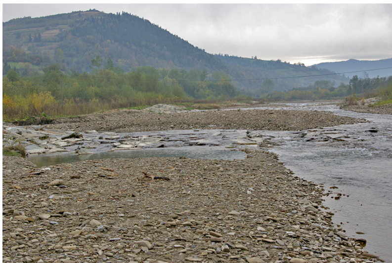
Ryc. 7. Widok na górne (i dolne) stanowisko bystrza o zwiększonej szorstkości pokryte żwirem poprzez wytworzenie lach korytowych zaraz po przejściu wezbrania – potok Porębianka (fot. A. Radecki-Pawlik)
