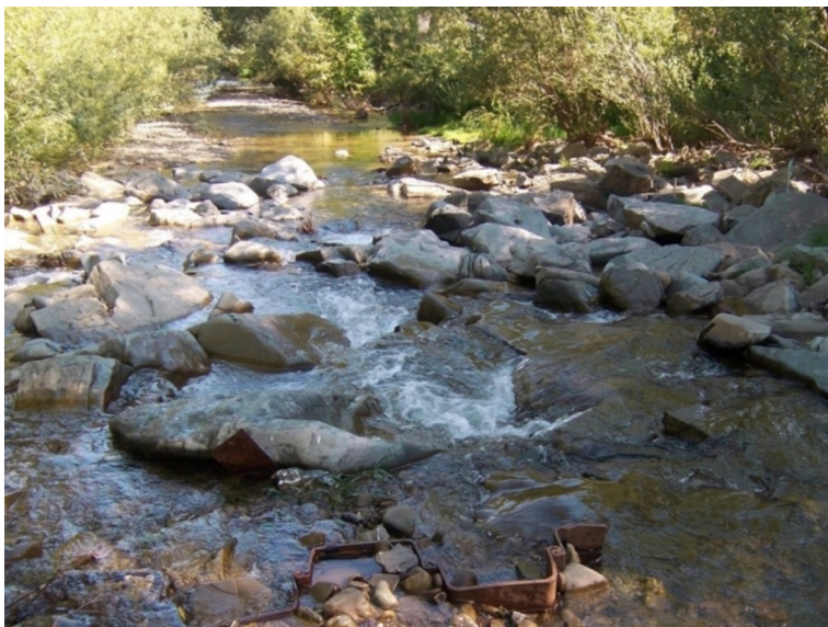
Ryc. 12. Widok na bystrze o zwiększonej szorstkości z gurtem ze ścianki stalowej Larsena – potok Poniczanka (fot. K. Plesiński)
