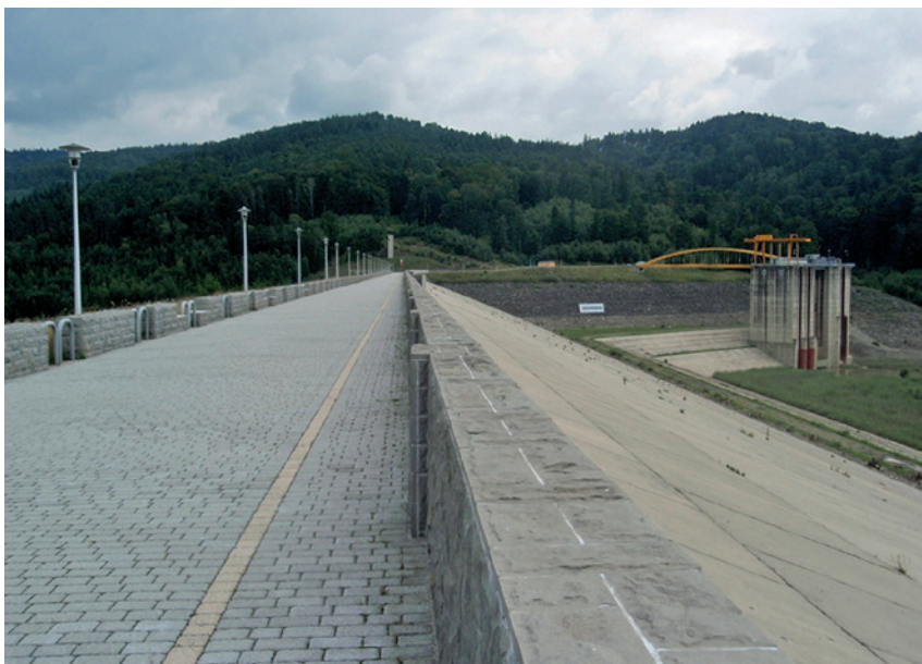
Ryc. 1. Korona zapory (fot. R. Kostuch) Fig. 1. Crown of dam (photo R. Kostuch)
