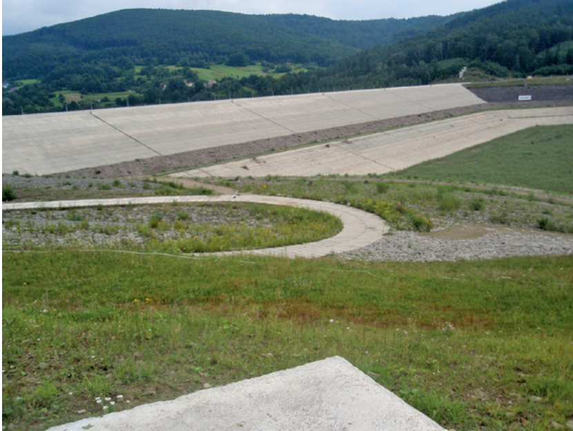
Ryc. 3. Zapora od strony czaszy zbiornika (fot. R. Kostuch)
