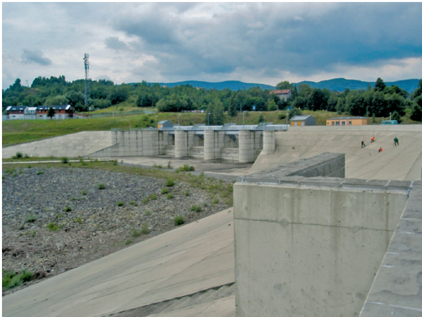
Ryc. 2. Sztolnia upustowa (fot. R. Kostuch) Fig. 2. Flood spilway (photo R. Kostuch)
