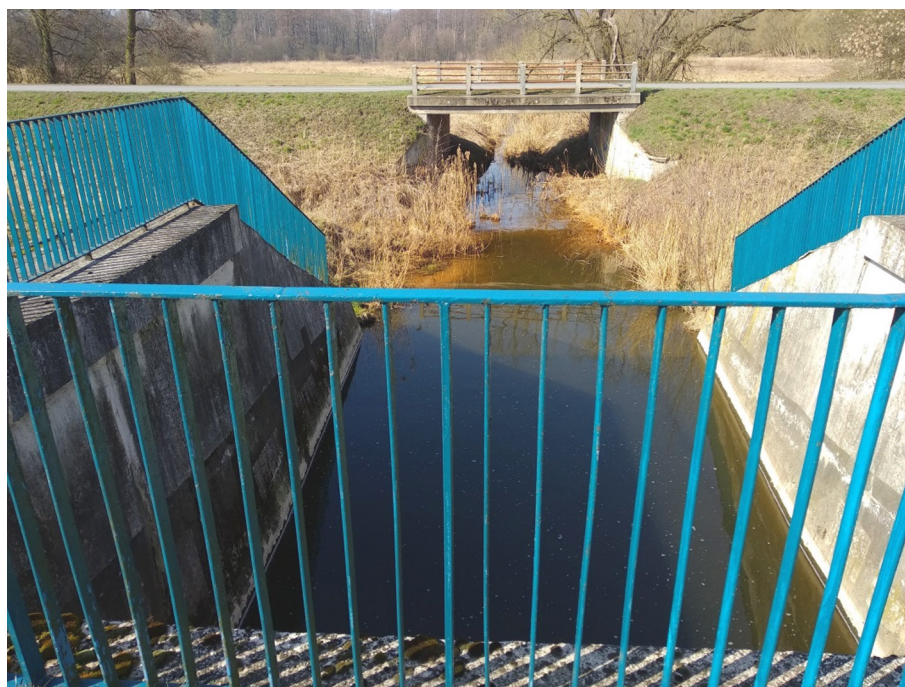
Ryc. 2. Punkt pobierania próbek wody na odpływie ze zbiornika (stanowisko 2)
