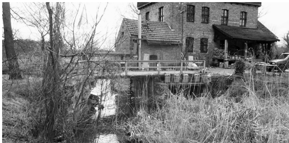
Ryc. 3. Stan jazu młyńskiego – przejście nad młynówką przy młynie
