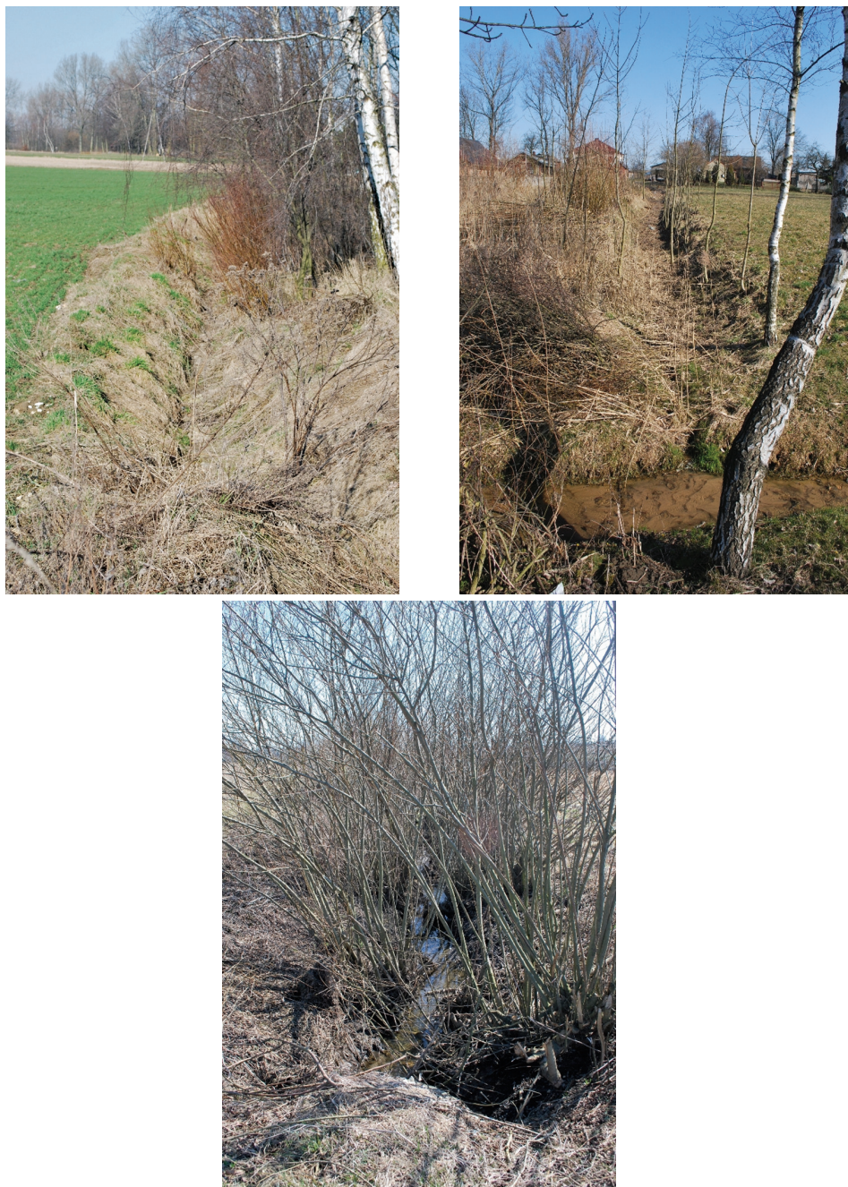
Ryc. 2. Przykłady rowów melioracyjnych w Marcinkowicach wymagające poprawy parametrów technicznych
