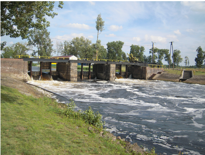
Ryc. 2. Stopień wodny Rosko na rzece Noteć: a – widok śluzy od górnej wody, b – widok jazu piętrzącego od dolnej wody (fot. J. Wicher-Dysarz)
