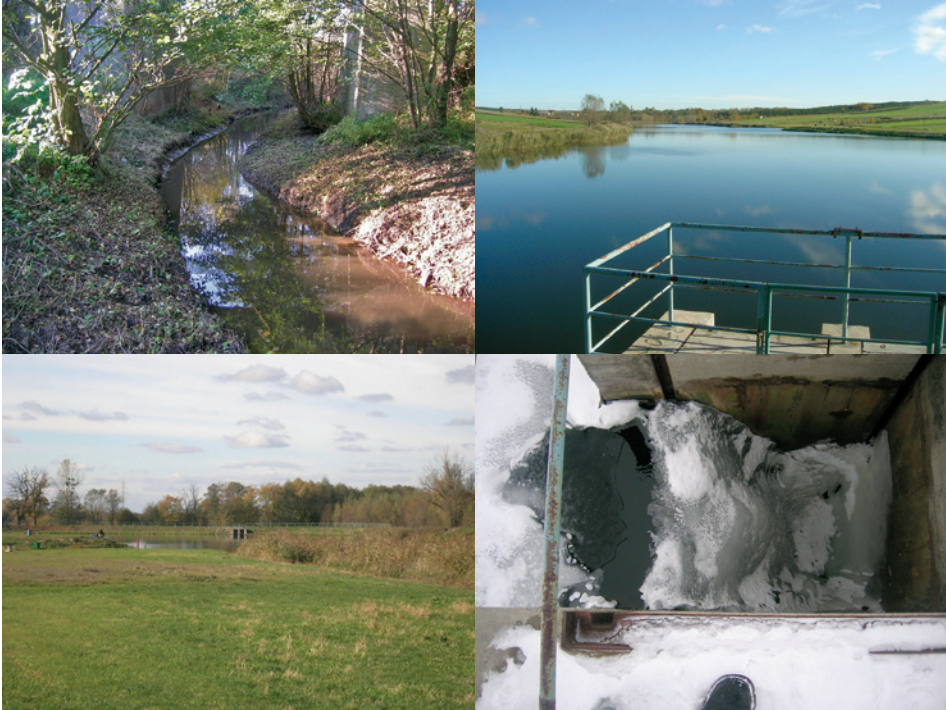
Ryc. 3. Julianpolka – dopływ do zbiornika Młyny i zbiornik wodny Młyny wraz zaporą czołową i budowlą upustową
