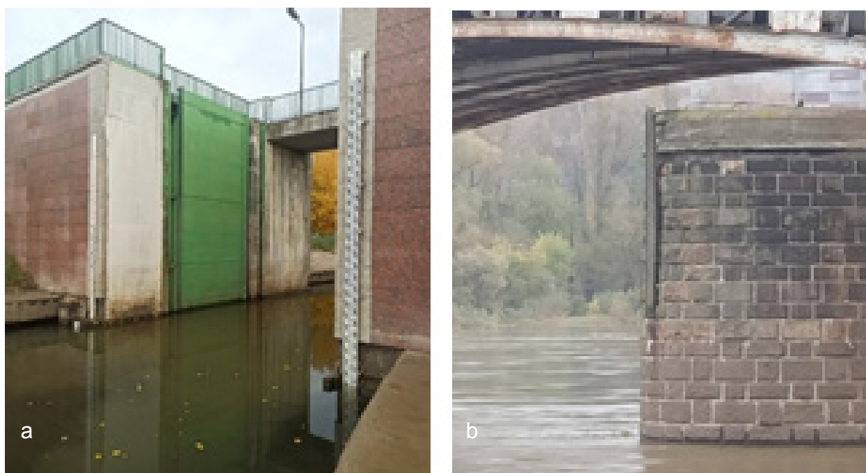
Ryc. 8. a) Wodowskaz Port Czerniakowski. Widoczne dwie łaty z zerami wodowskazu na różnych poziomach; b) Pozostałości łaty wodowskazowej na filarze kolejowego mostu średnicowego (fot. M. Wasilewicz)
